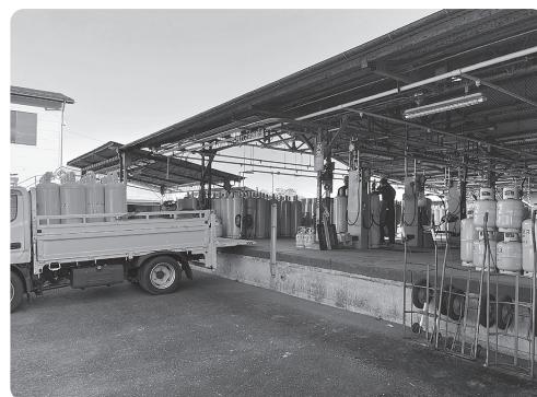
充填作業の様子
